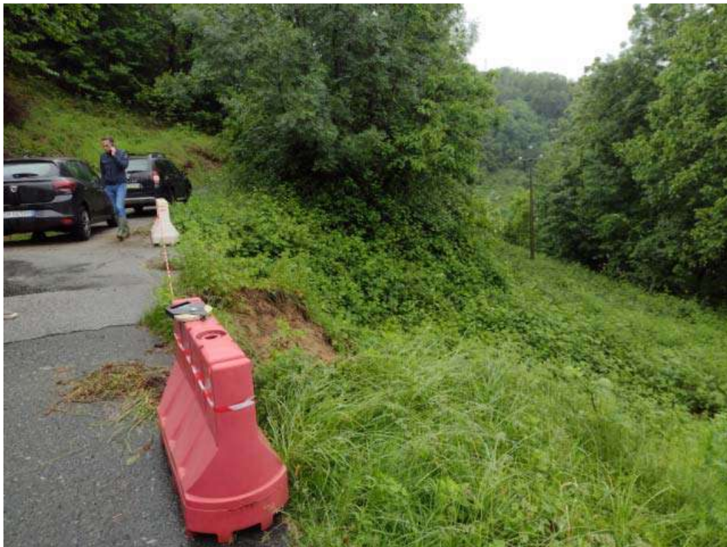
Figura 4: via Rossi - particolare della banchina interessata dal cedimento
